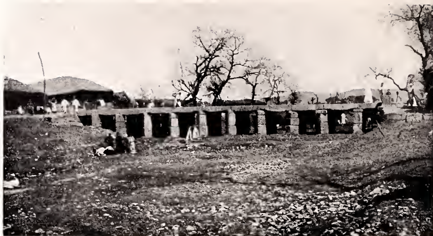
Brücke in Souwon
